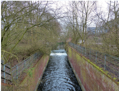
Absturz des Wasserspiegels, Überfallwehr
