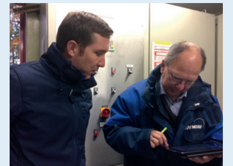
Umweltgutachter Herr Dr. Nehm begutachtet die Abwasserpumpanlage Menzelen-Ost
