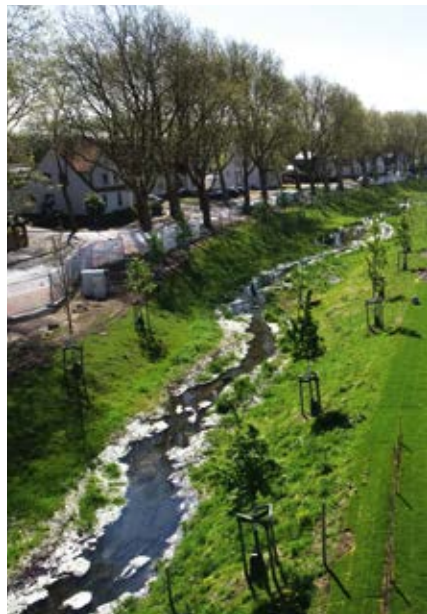
// NATURNAHER AUSBAU DER GROSSEN GORLEY IN KAMP-LINTFORT.
